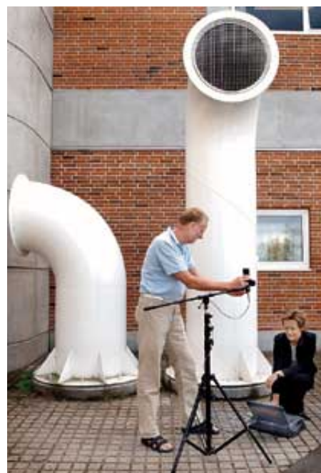
Frequenzmessung an Belüftungssystem* Enttarnung des Brummtongespens
